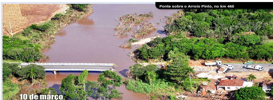
Figura 35: Ponte sobre o Arroio Pinto por Jornal Zero Hora
